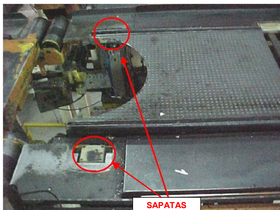
Figura 50 - Vista das sapatas traseiras
