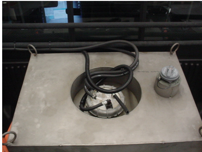
Figura 23. Detalhe de instalação do tanque de combustível sobressalente.
